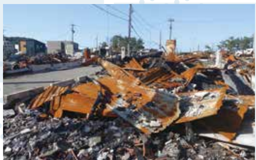
火災に遭った輪島市の朝市通り（石川県輪島市）
